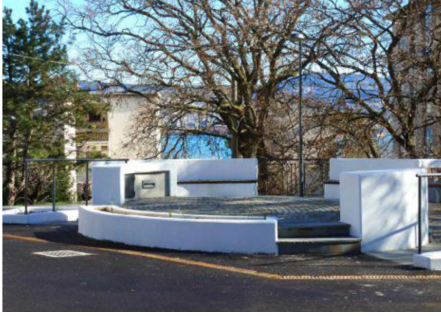
Resim-4 Tamamlanmış, Yeni Borgo Zindis Merkezi Meydanı
